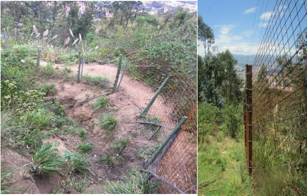
Fotografías arriba izquierda y derecha de la fosa excavada con paredes naturales de tierra de dos metros de profundidad en donde está la cerca perimetral que al interior del recinto tiene los alambres galvanizados que conforman la cerca eléctrica y afuera del recinto presentan la malla electro soldada amarrada o soldada a los postes galvanizados y de madera. © Ernesto Arbeláez
