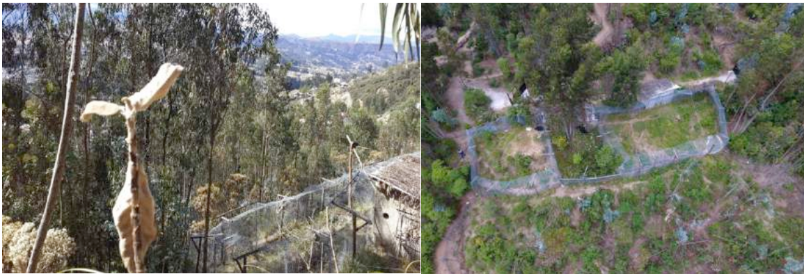
Fotografías arriba izquierda y derecha que detallan la vista desde una perspectiva superior de los cubiles o áreas de manejo interno. Nótese los tubos galvanizados perimetrales que en el lado superior tienen los ángulos soldados a 90 grados, la malla dispuesta en paredes y sobre los ángulos forman un alero de malla de un metro de longitud por lo que esto promueve que el área no use techo de mallas. Fotografías de abajo izquierda derecha que detallan las paredes verticales usadas como métodos de contención de las nuevas áreas de cubiles de manejo y zonas de aislamiento en el ABC © Ernesto Arbeláez
