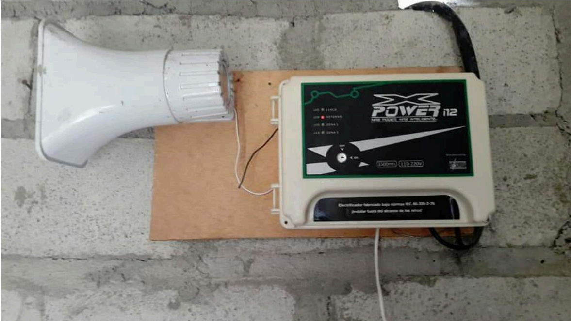
Fotografía arriba del tipo de equipo de motor eléctrico usado para electrificar los perímetros de los recintos de contención de los osos andinos. © Ernesto Arbeláez
